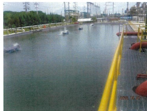
ภาพที่ 2-33 บ่อน้ำดับเพลิงสำรอง (Fire Pond)
