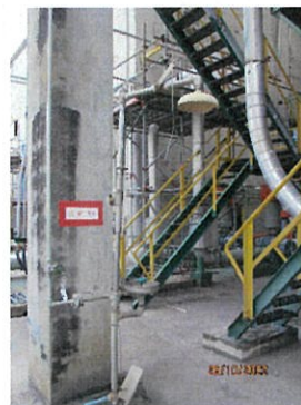
ภาพที่ 2-28 ฝักบัวฉุกเฉินและที่ล้างตาฉุกเฉิน
