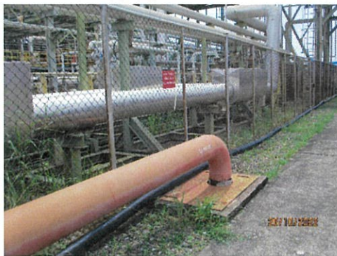
ภาพที่ 2-32 ท่อรับน้ำดับเพลิง จากบริษัท พีทีที โกลบอล เคมิคอล จำกัด (มหาชน)
