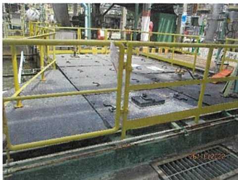
ภาพที่ 2-7 บ่อ Oil-Waste Separator
