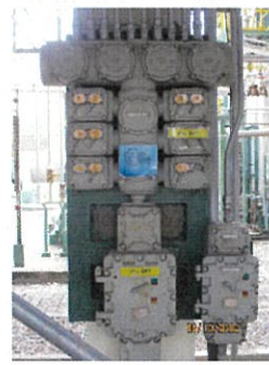
ภาพที่ 2-21 ระบบไฟฟ้าแบบ Explosion Proof
